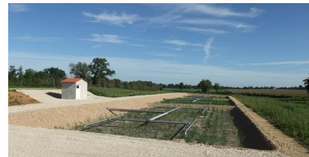
Station d'épuration de Magné – Photo : Département 86
