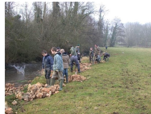
Chantier jeune animé par le syndicat mixte du Clain sud : aménagement dans un bras de la Dive de Couhé à Vauguibert – Photo : SMCS
