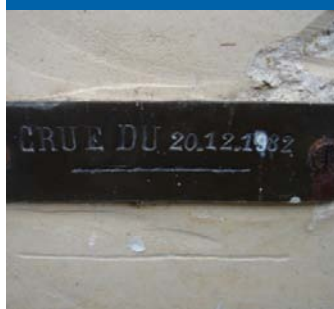
Repère de crue sur la Vonne
