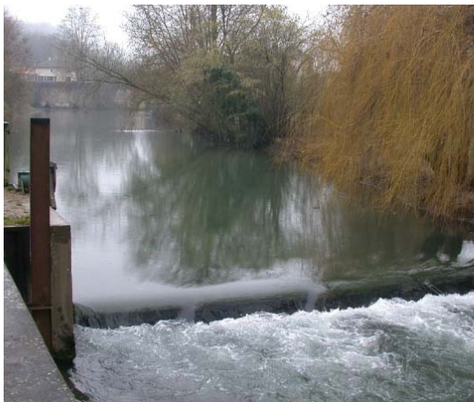
Clapet de l'abattoir sur la Dive avant abaissement. Le clapet a été abaissé pour assurer la continuité écologique et des micro-seuils en aval ont été mis en place pour maintenir la ligne d'eau (Photos : Syndicat du Clain Sud)
