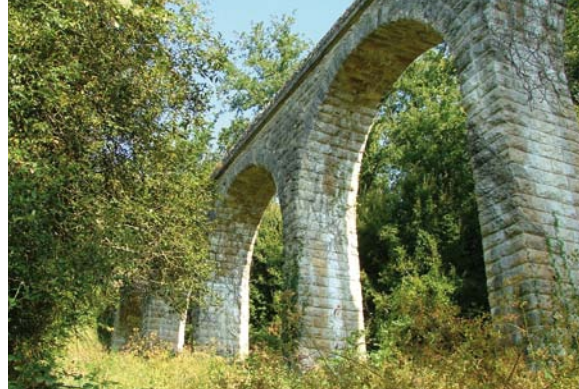
Aqueduc de Fleury à Vouneuil-sous-Biard
